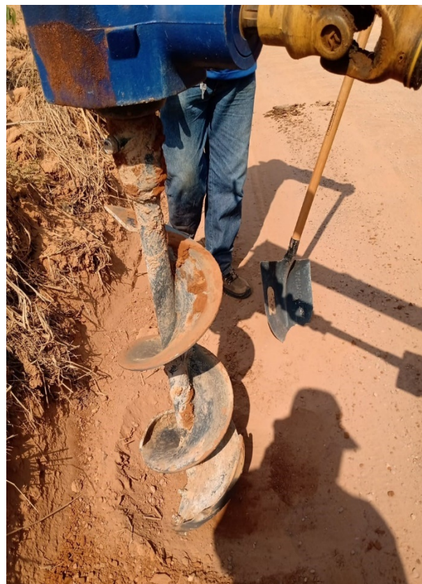
– Sondagem e Coleta de Amostra
